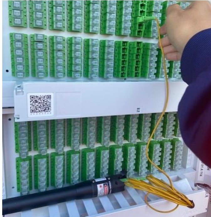
Figure 21 : test de continuité avec laser et bobine depuis la PM
